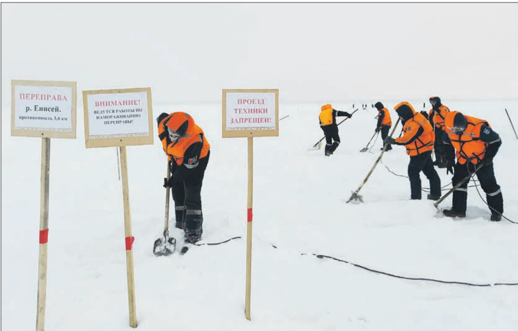
На фото: намораживание ледовой переправы в с.п. № 22
